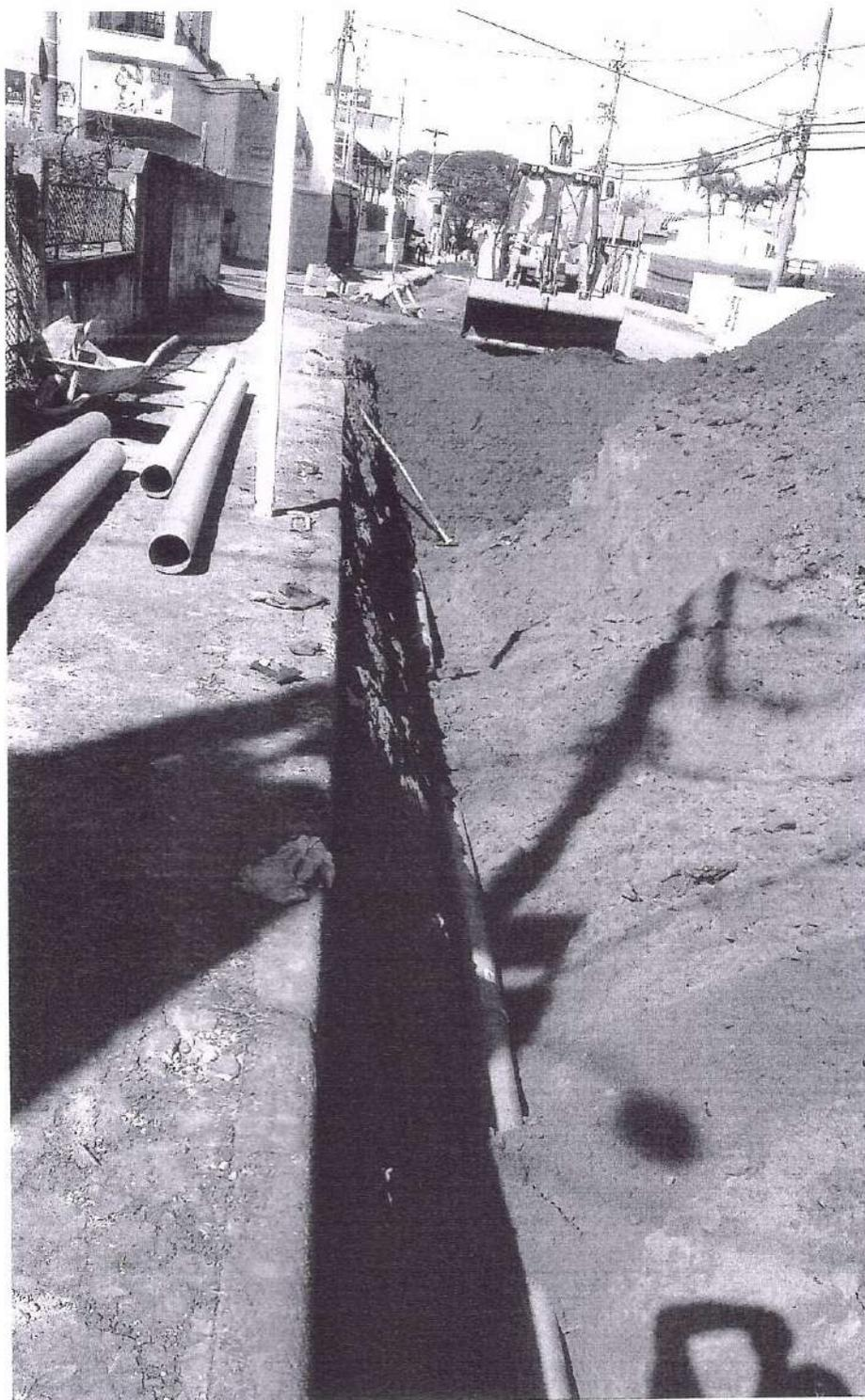
Figura 1: Rede coletora de esgotos colocada sobre a Galeria
