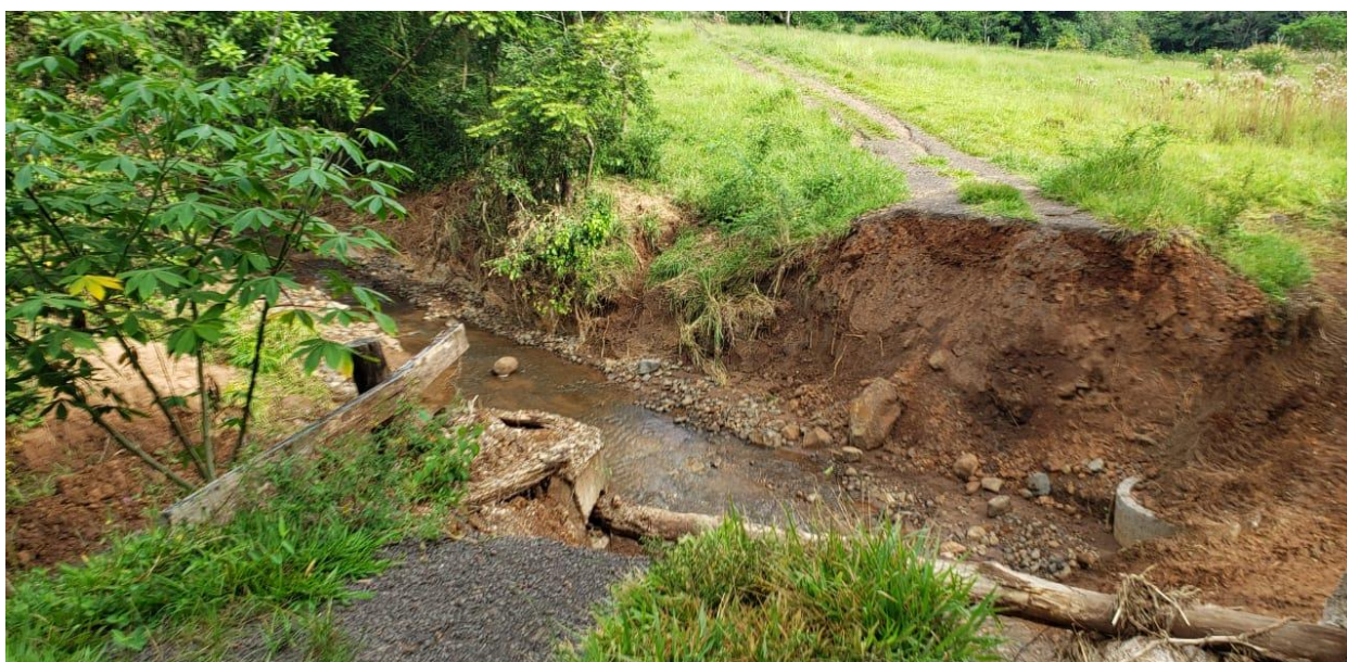
Foto: Ponte do Pátio 08 (Pontes de madeira).
