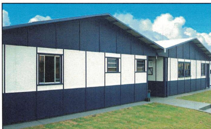
Figura 3 – Exemplo de Sistema modular pré-fabricado de madeira tratada modelo standard (Canteiro Construções Racionalizadas Ltda, http://www.canteirodeobras.com.br )
