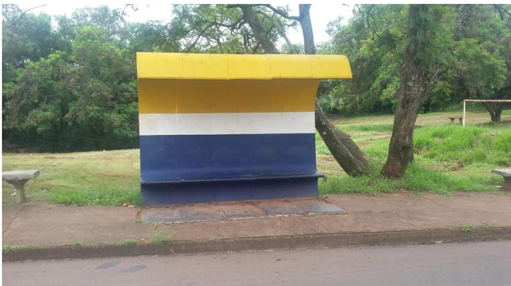
Figura 1. Abrigo existente Rua Pedro Delmanto Sobrinho lado oposto ao nº 319.
