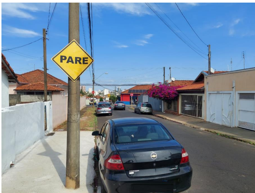
Figura 2. Sinalização vertical e horizontal de regulamentação de parada obrigatória.
