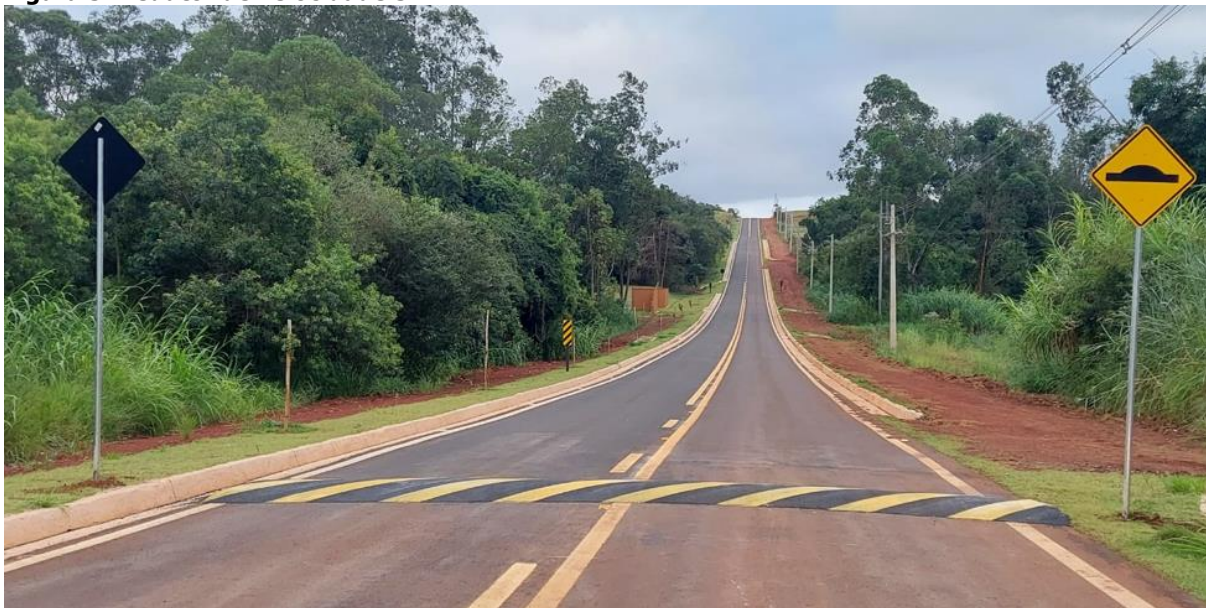
Figura 5. Redutor de velocidade 5.
