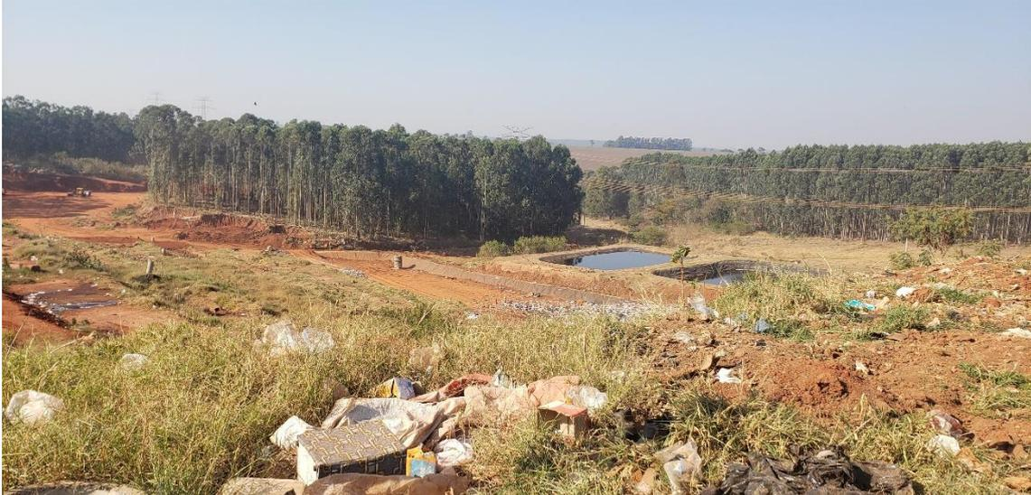
Lago de tratamento de chorume. Ao fundo área de eucaliptos que será utilizada para ampliação do aterro.
