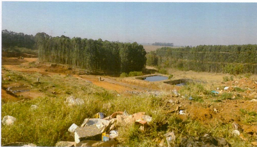
Figura 25: Aterro Sanitário: Vista das lagoas para tratamento do chorume.
