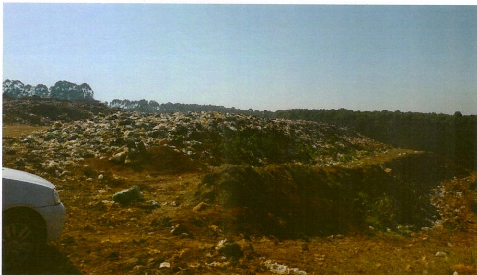
Figura 24: Aterro Sanitário: Frente de trabalho com resíduos ainda não cobertos
