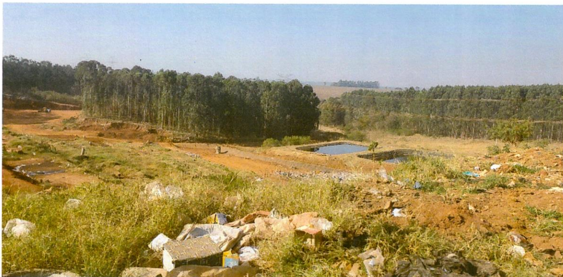
Lago de tratamento de chorume. Ao fundo área de eucaliptos que será utilizada para ampliação do aterro.
