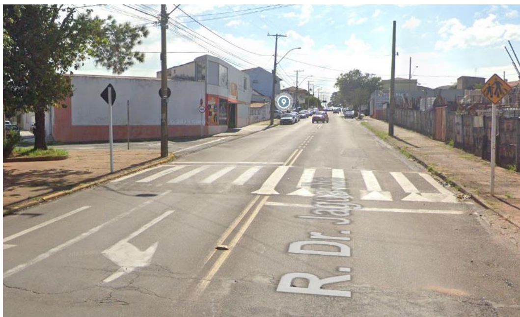
Figura 1. Faixa elevada para pedestres.
