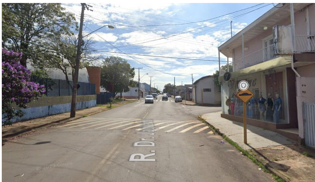
Figura 2. Redutor de velocidade do tipo lombada.
