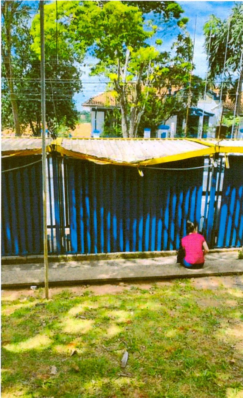
Vista do fundo do abrigo – cobertura destruída pela queda de uma árvore.
