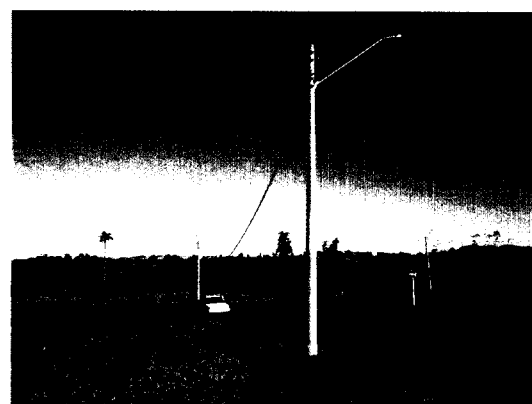
F 30 - Mostra rede de energia com problemas de inclinação.
