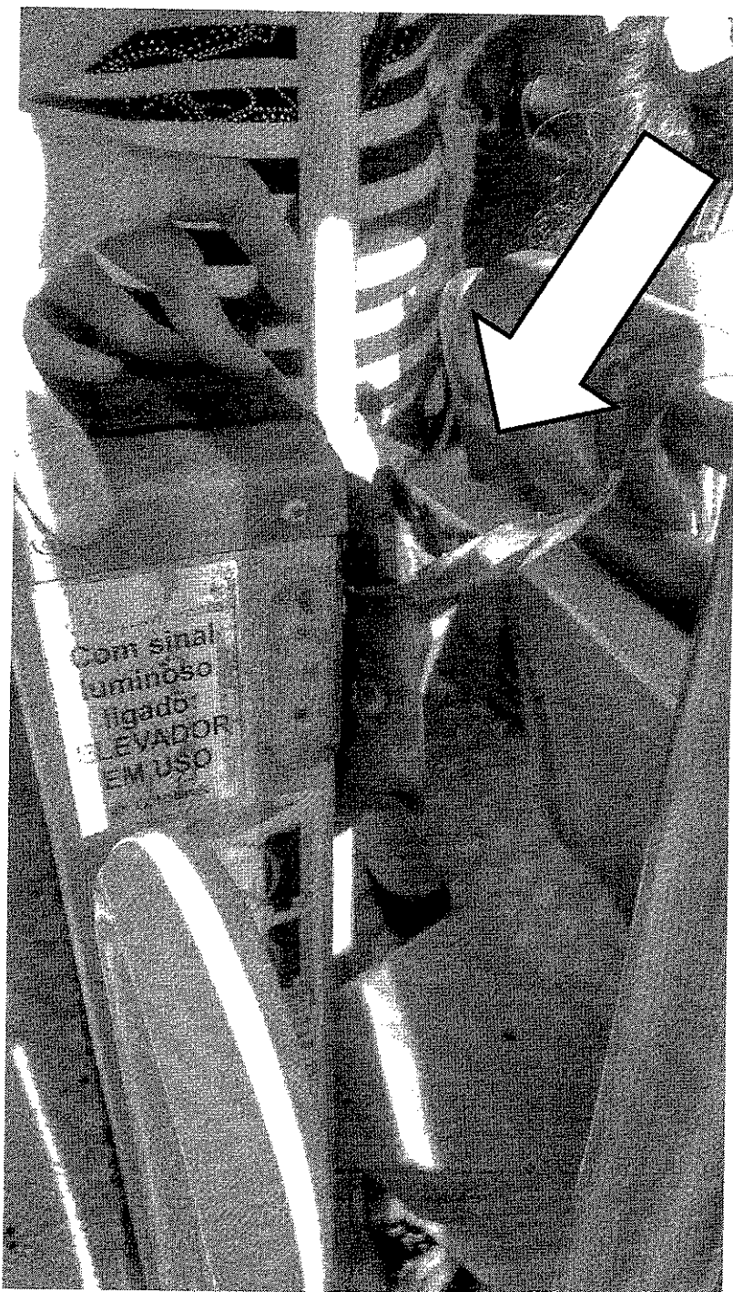
Figura 2. Detalhe do sistema inexistente de controle e operação do elevador.
