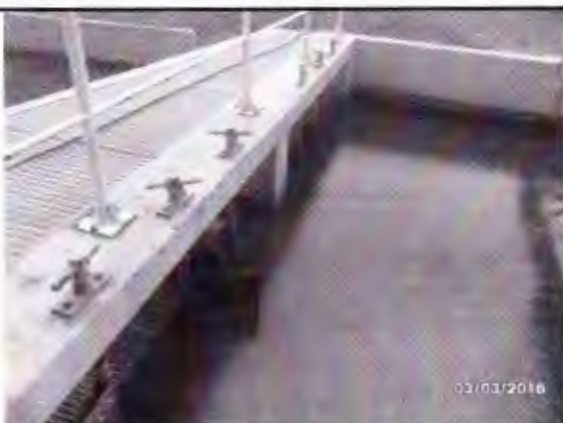
Foto 31 – ETE Lageado- desarenador.
