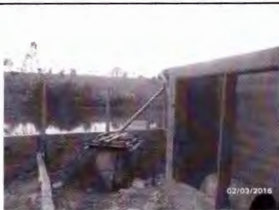
Foto 20 – EEAB Rio Bonito.
