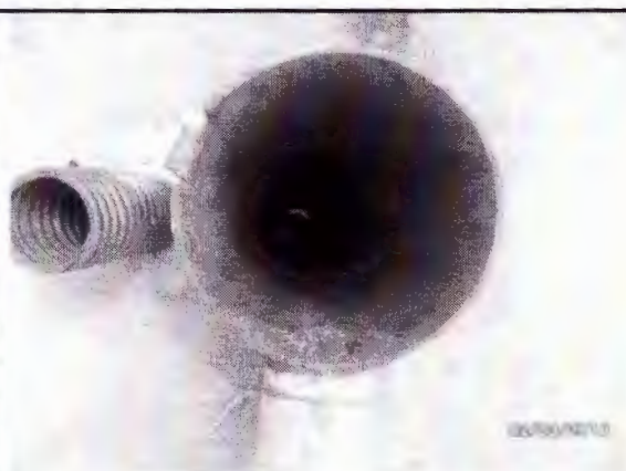
Foto 6 – Poço P4 desativado.
