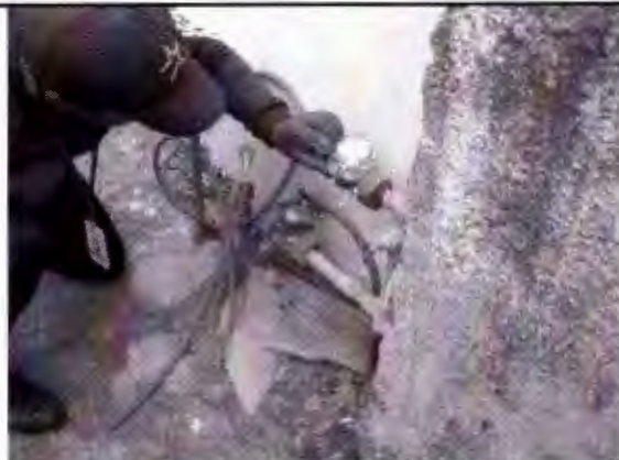
Foto 12 – Foi constatado que o hidrometro estava quebrado.
