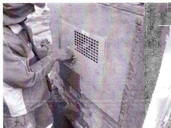
Foto 8 – Instalação do Hidrometro com lacre.
