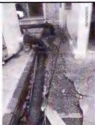
Foto 17 – ETA Rio Bonito.
