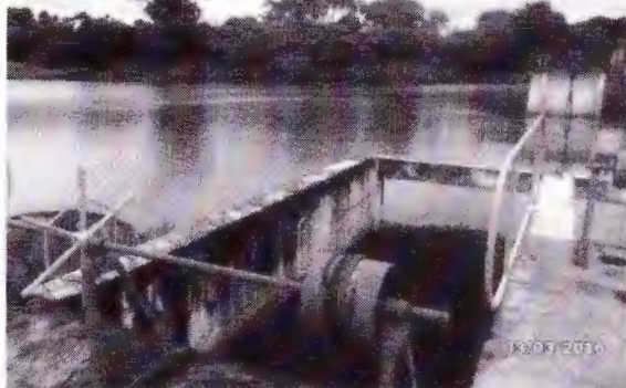
Foto 3 – Captação Rio Pardo: macrofitas.
