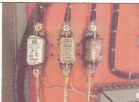
Foto 73 – EEE Jardim Botucatu II: fusíveis com diferentes amperagens
