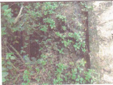
Foto 89 – EEE Jardim América: esgotos
