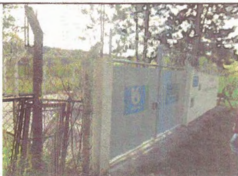
Foto 65 – EEE Bela Vista: vista geral.
