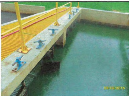
Foto 31 – ETE Lageado- desarenador.
