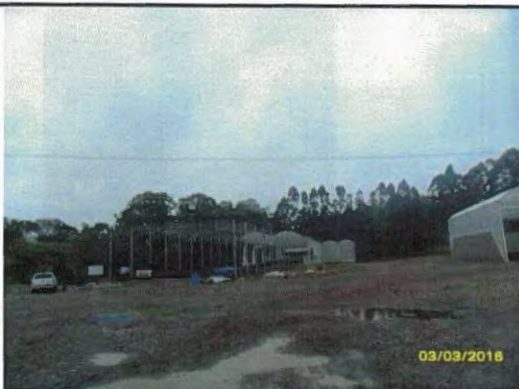
Foto 33 – ETE Lageado: galpão de disposição do lodo.
