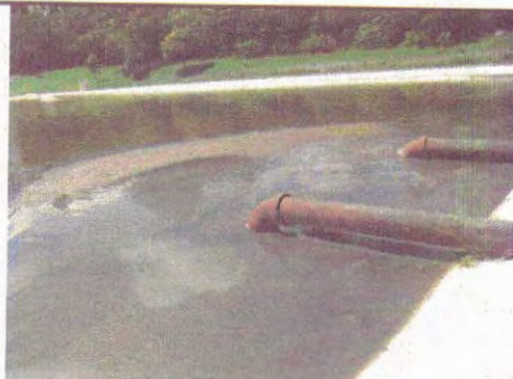
Foto 98 – ETE Rubião Júnior: assoreamento na entrada da lagoa semi-aerada.
