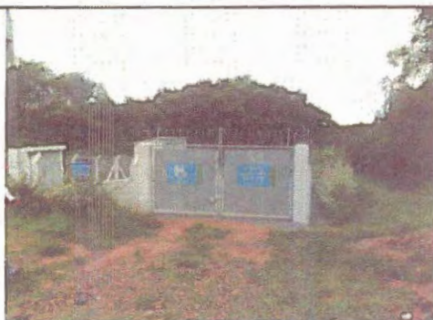
Foto 57 – EEE Jardim Paraíso II: vista geral.
