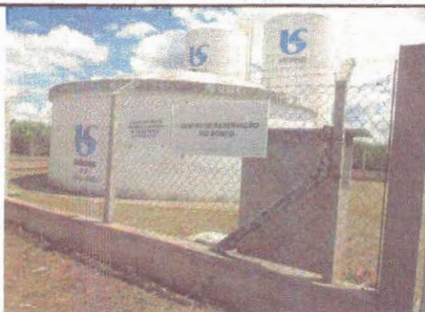
Foto 25 – Centro de reservação de água tratada.
