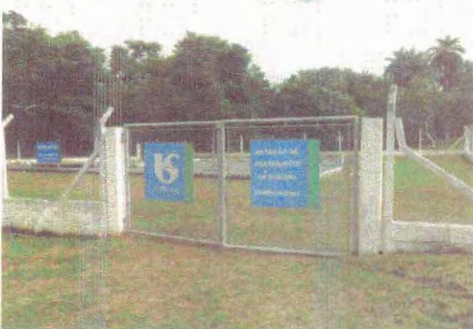
Foto 105 – ETE fossa filtro.
