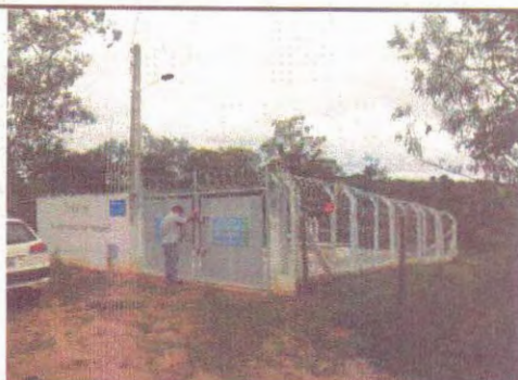
Foto 75 – EEE Jardim Botucatu III: vista geral.
