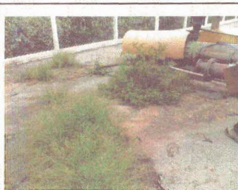
Foto 58 – EEE Jardim Paraíso II- falta de limpeza e conservação.
