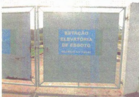
Foto 31 – EEE Havaí: vista geral.
