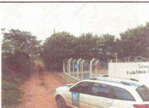
Foto 79 – EEE Nossa Senhora Aparecida: vista geral.
