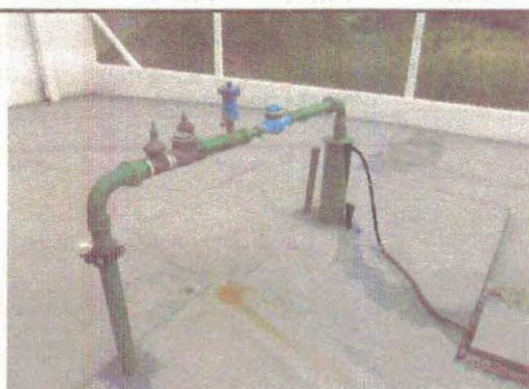
Foto 13 – Poço P3: Vista geral.
