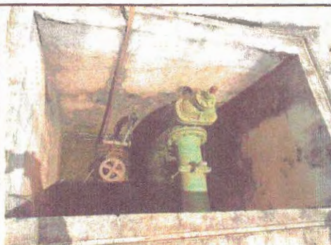
Foto 26 – Centro de reservação de água tratada: caixa da válvula de manobra.
