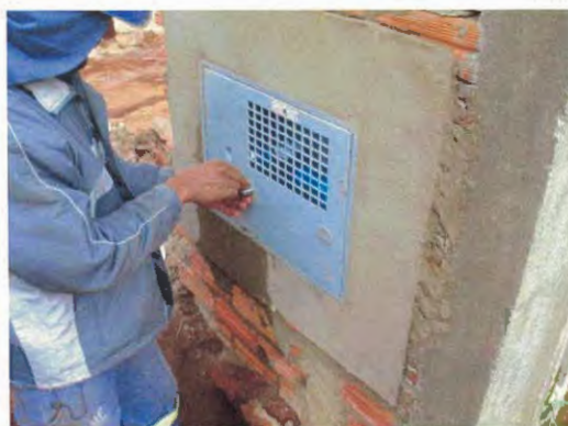
Foto 8 – Instalação do Hidrometro com lacre.
