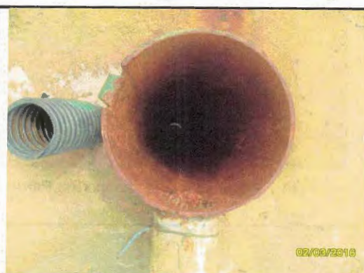
Foto 6 – Poço P4 desativado.
