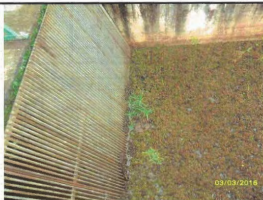
Foto 4 – Captação Rio Pardo: macrofitas.
