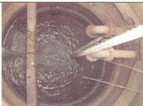
Foto 77 – EEE Jardim Botucatu III: vista geral
