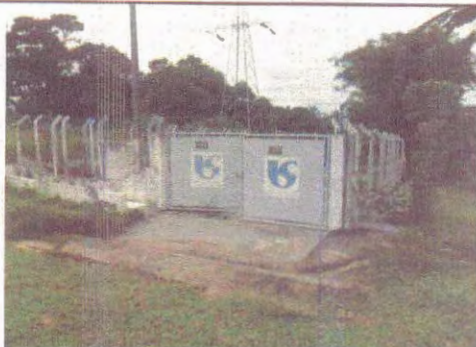
Foto 47 – EEE Jardim Tropical: vista geral.
