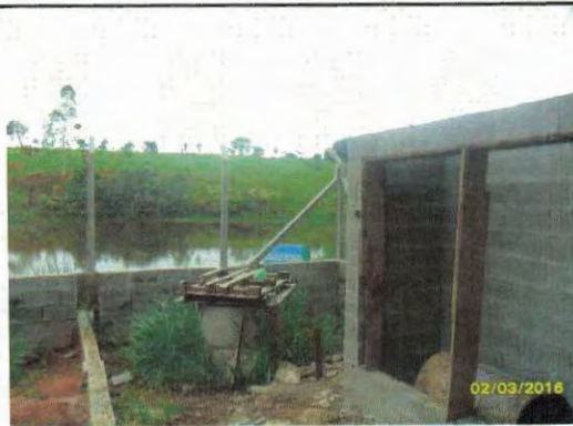
Foto 20 – EEAB Rio Bonito.
