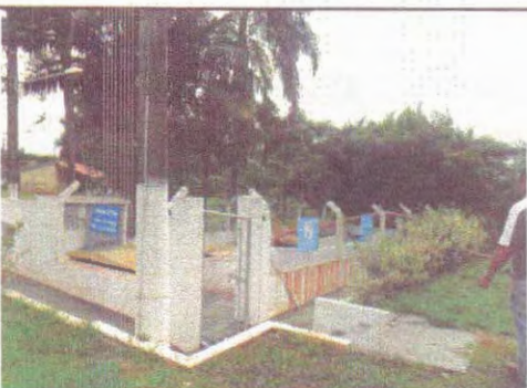
Foto 51 – EEE Capão Bonito.
