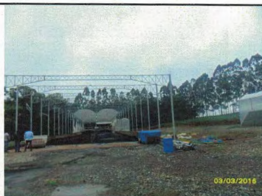
Foto 34 – ETE Lageado: galpão de disposição do lodo.
