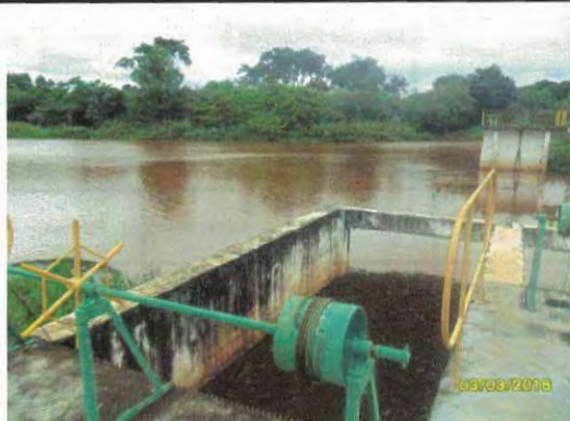
Foto 3 – Captação Rio Pardo: macrofitas.
