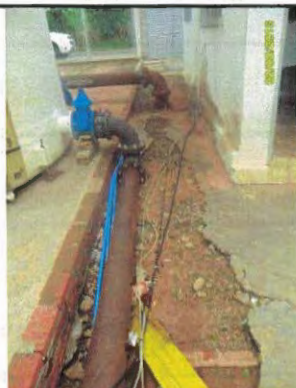
Foto 17 – ETA Rio Bonito.
