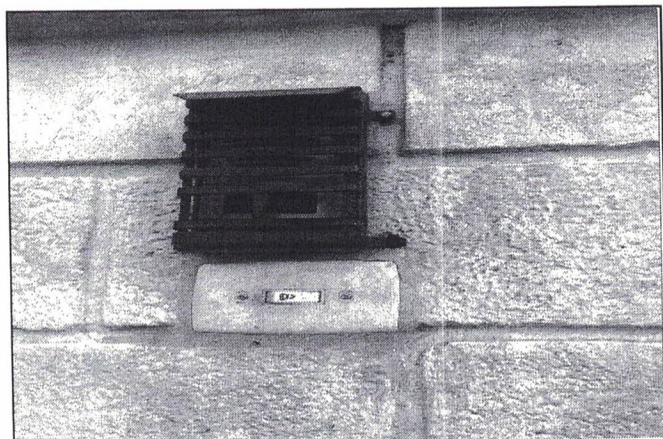
Portão eletrônico em perfeitas condições
