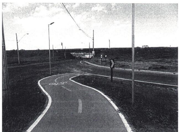
Foto 4 – Vista do trecho de Ciclovia executada no canteiro do dispositivo (lado Oeste). Obra interrompida.
