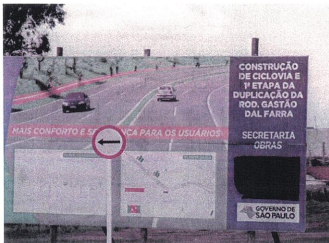
Foto 1 - Placa Institucional da Obra
