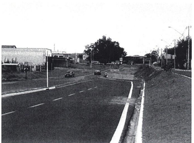
Foto 6 – Vista do final do trecho duplicado (Extensão 870 m).
