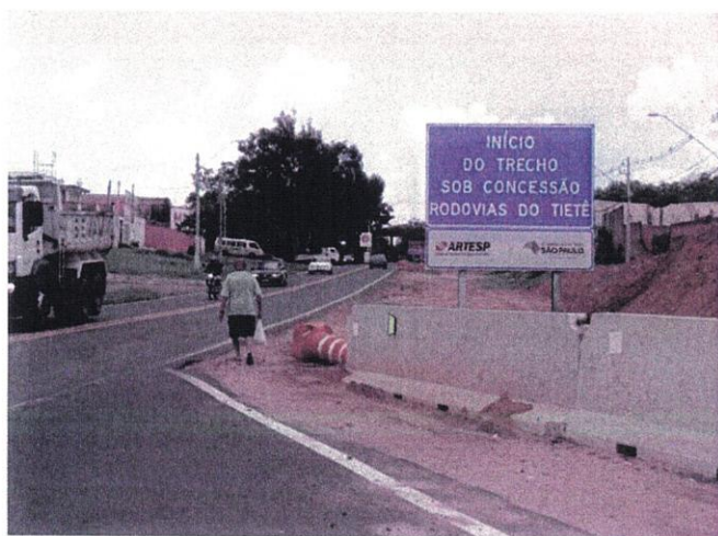
Foto 7 – Início do trecho sob Concessão Rodovias do Tietê. Obra embargada pela Tietê.
