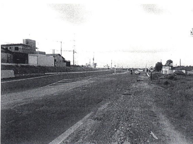
Foto 12 – Limite do trecho Rodovias do Tietê e Prefeitura de Botucatu. Vista sentido SP 300
