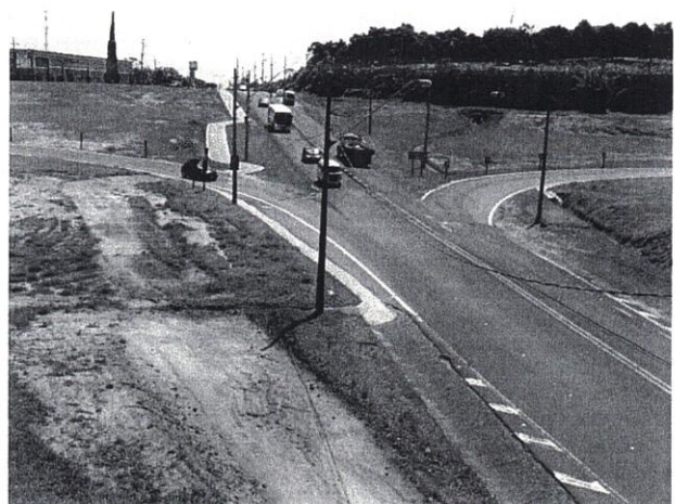
Foto 2 – Vista do trajeto onde seria executado a Ciclovia. Serviços no canteiro do dispositivo km 253+700 (Botucatu) interrompidos.
