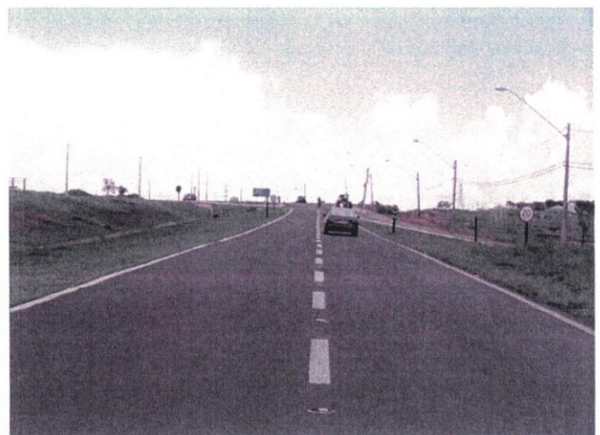
Foto 2 - Início do trecho duplicado (SPA-241 - Rod. Gastão Dal Farra).
