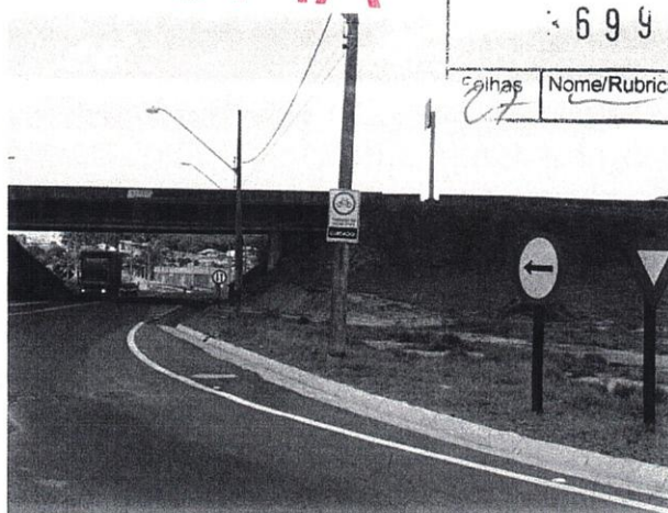
Foto 6 – Vista do trajeto onde seria executado a Ciclovía (Passagem sob o viaduto). Obra paralisada.
