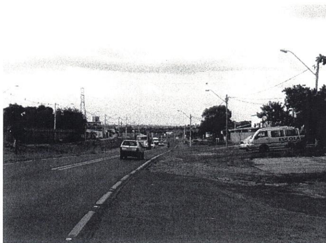
Foto 11 – Obra de duplicação paralisada. Vista sentido SP 300.
