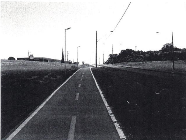
Foto 3 – Vista do trecho de Ciclovia executada no canteiro do dispositivo (lado Oeste). Obra interrompida.
