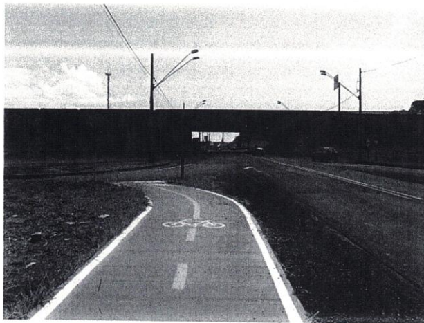
Foto 11 – Vista do trecho de Ciclovía executada no canteiro do dispositivo (lado Leste). Obra interrompida.
