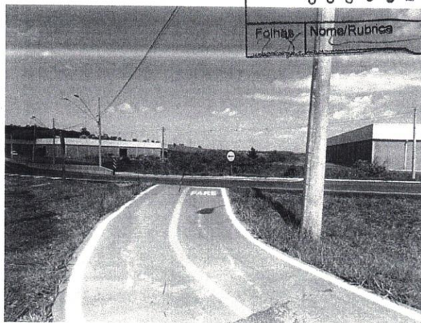
Foto 12 – Vista do trecho de Ciclovía executada no canteiro do dispositivo (lado Leste). Obra interrompida.
