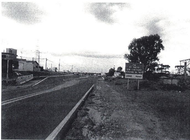
Foto 11 – Vista da Obra embargada pela Rodovias do Tietê. Trecho sob Concessão.
