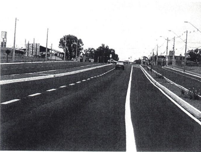
Foto 5 – Obra de Duplicação realizado pela Prefeitura de Botucatu.
